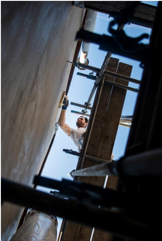
De gevel aan de achterzijde van Domplein 12 is in 2021 gestuct. (Foto: Marieke Wijntjes)
