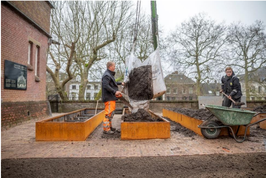
De nieuwe cortenstalen bakken worden gevuld (Foto: André Russcher)
