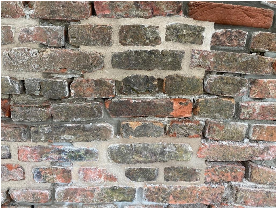
Voegproeven op de bastionmuur om de kleur en hechting te beoordelen.
